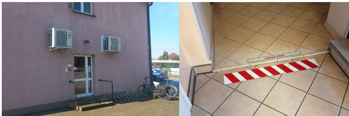
Ryc. 36. Budynek, w którym mieści się siedziba MGOPS
