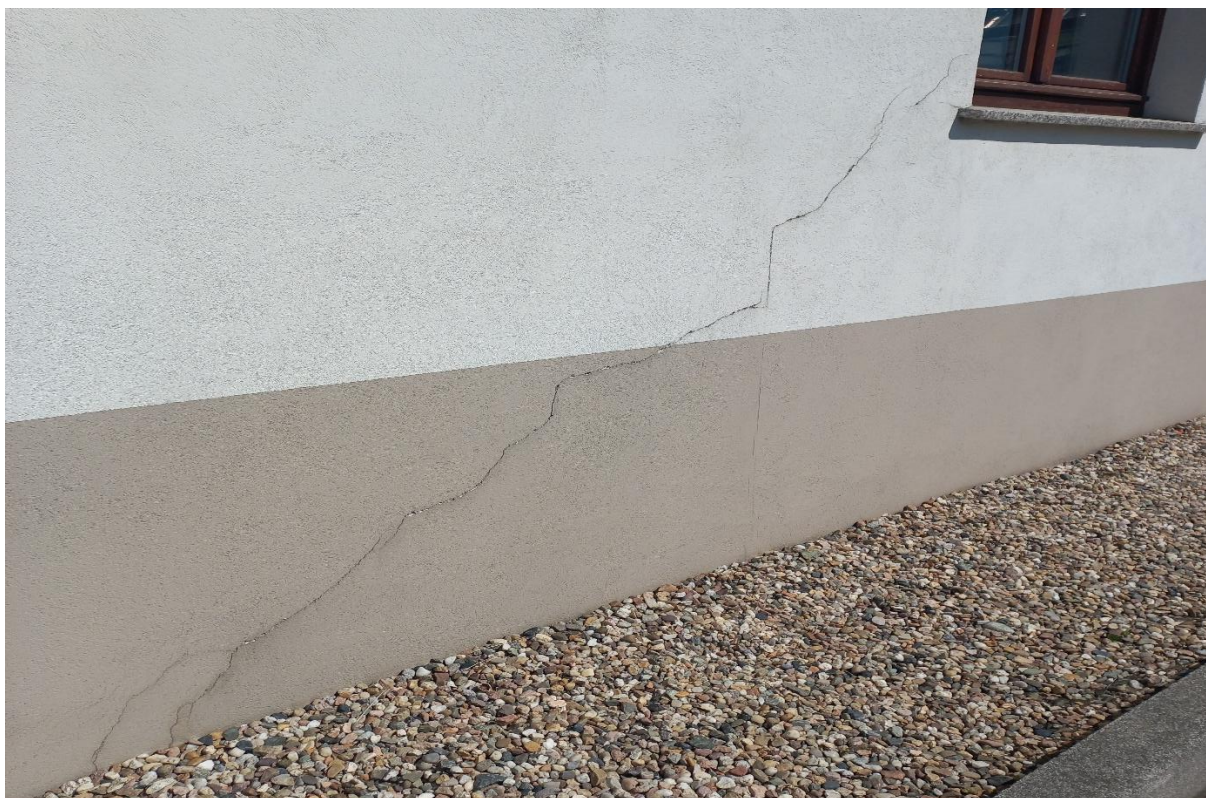
Ryc. 28. Elewacja sali widowiskowej GOK w Kobylinie
