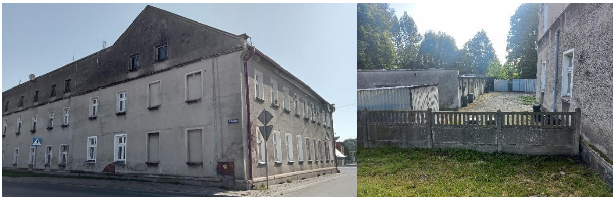
Ryc. 30. Budynek komunalny zlokalizowany przy Alejach Powstańców Wielkopolskich 54
